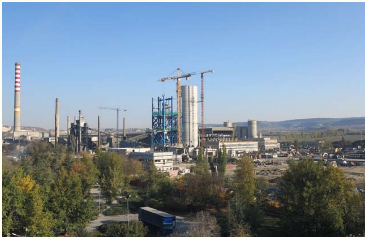
公司正在建设的保加利亚Devnya项目
