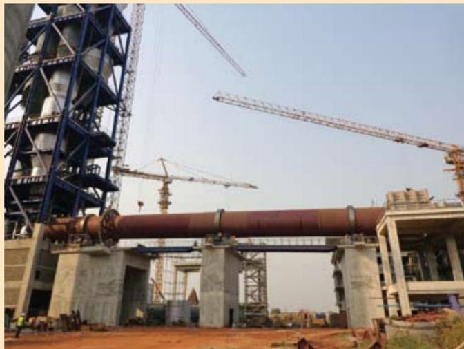
在项目部前期的精心组织和现场施工队伍的积极配合下，贝宁项目回转窑最后一节于2014年元旦安全顺利地完成吊装，实现合龙。回转窑吊装完成是熟料线施工的一个重要节点，贝宁项目部全体人员将会以此为契机，继续努力，保证整个熟料线按时生产和交工。（贝宁项目部）
